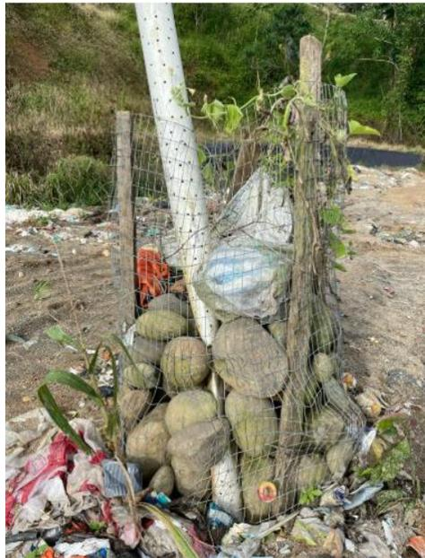
**Ilustración 10.** Chimenea obstruida dentro de la celda de disposición final.
