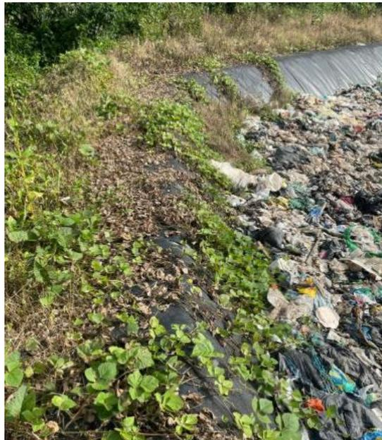
**Ilustración 8.** Estado de las zanjas de coronación.
